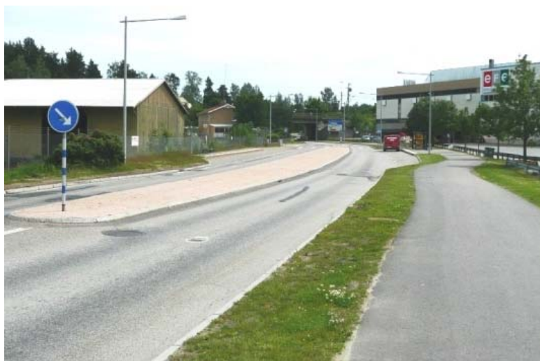
Holavedsvägen med Pumpen 8 till vänster
