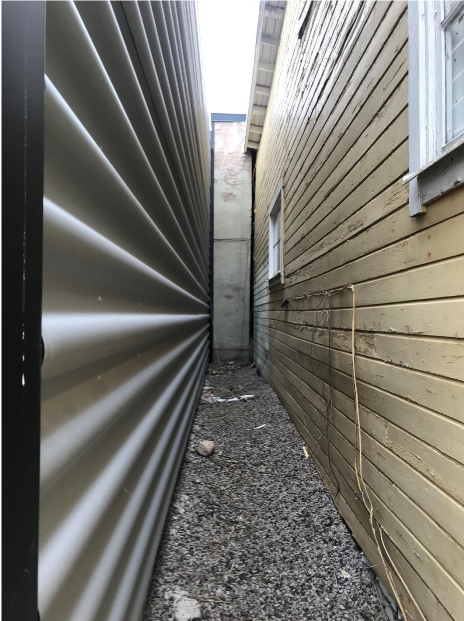
Figur 4. Tidigare placering av cistern. Angränsande till Fiskmåsen 14.
