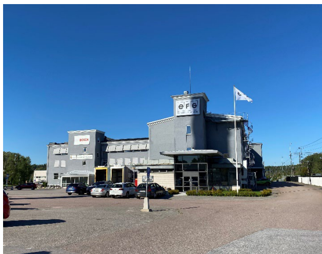
Figur 11. Byggnad från söder och norr.
