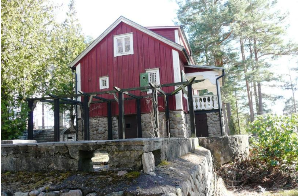
Befintlig byggnad på Kungsbacken 3:2
