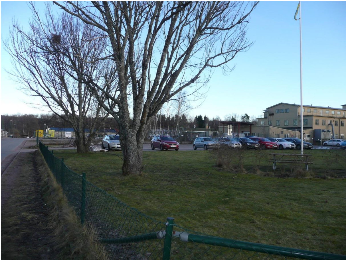
Grönytan i nordvästra delen av planområdet mot Torsgatan. Bakom träden skymtar grusplanen på Nötskrikan 8 och till höger syns befintliga byggnader på Nötskrikan 10 som ska rivas.
