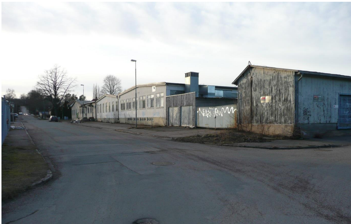
Överst: Byggnaden på Nötskrikan 12 sett från nordöst (tv) med villa längs Vasagatan som skymtar samt från sydväst från Vasagatan (th). Nederst: Befintliga byggnader på Nötskrikan 10 mot Forsgatan i södra delen av planområdet.
