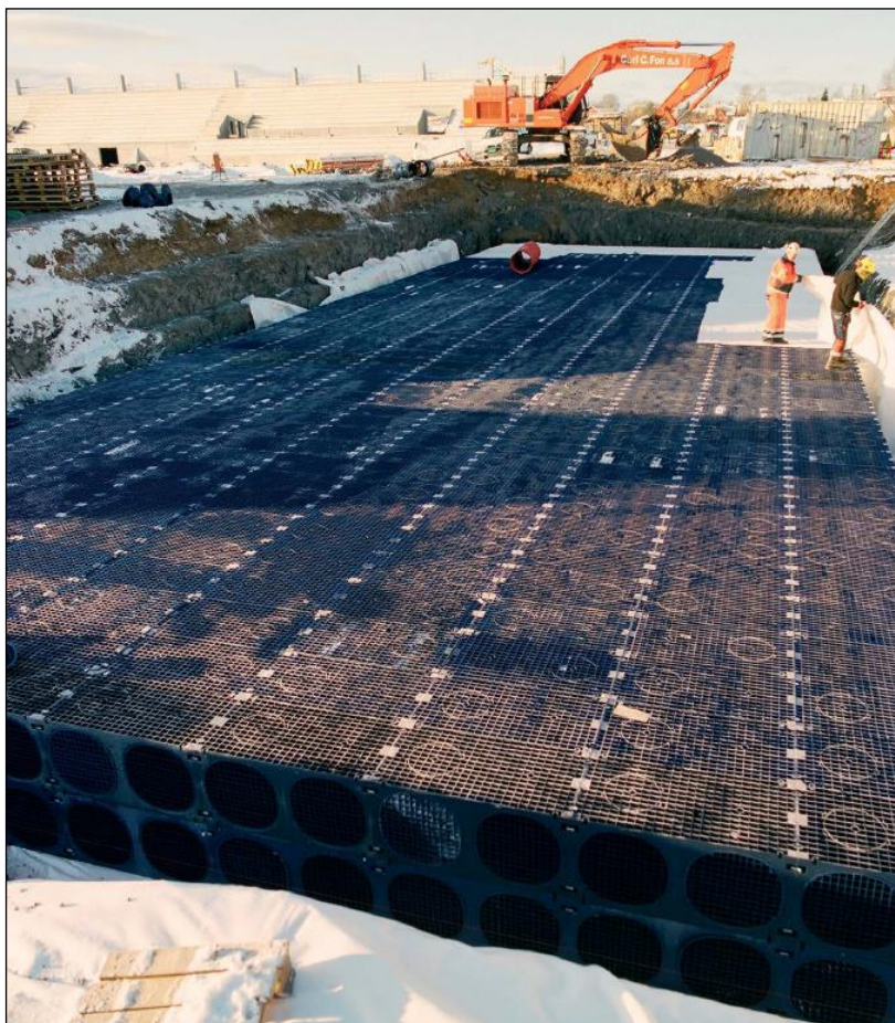
Figur 15. Exempel på utjämningsmagasin i form av dagvattenkassetter (Foto: Wavin)
