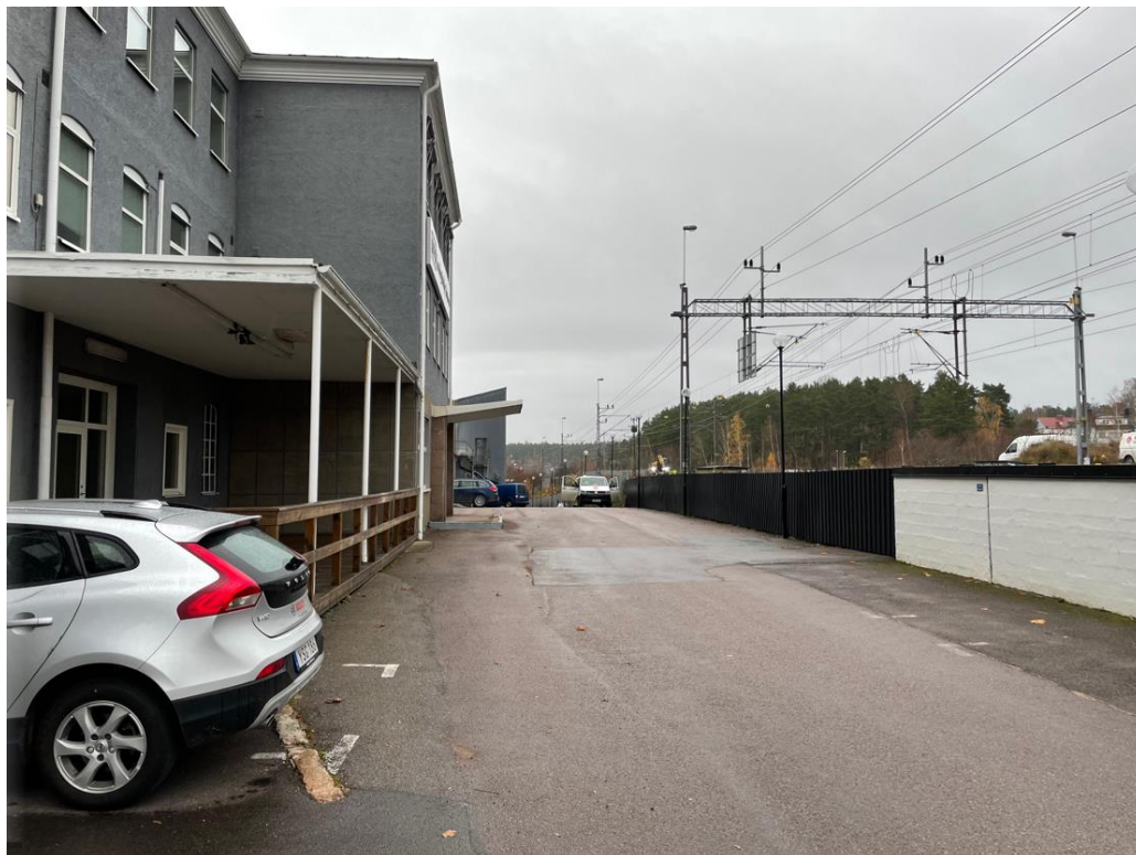
Figur 8. Vuxenskolans fasad (t.v.) och spårområdet samt befintlig bullerskärm (t.h.).
